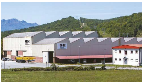
Bakaiku Planta de Calderería / Boilermaking Plant
