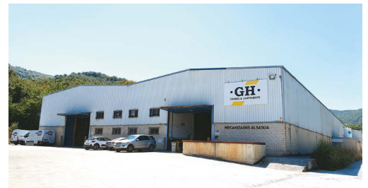
Alsasua Planta de Mecanizado / Machining Plant
