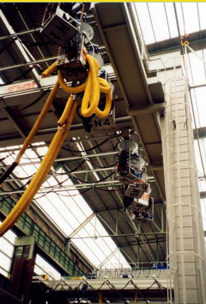
■ SYSTÈME D'EXTRACTION DE GAZ SOUDURE
