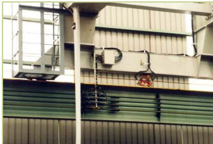
■ LIGNE D'ALIMENTATION DE PONT ET ÉQUIPEMENTS DE SOUDURE
