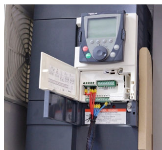
12 / Frequenzumrichter Längsfahrt
