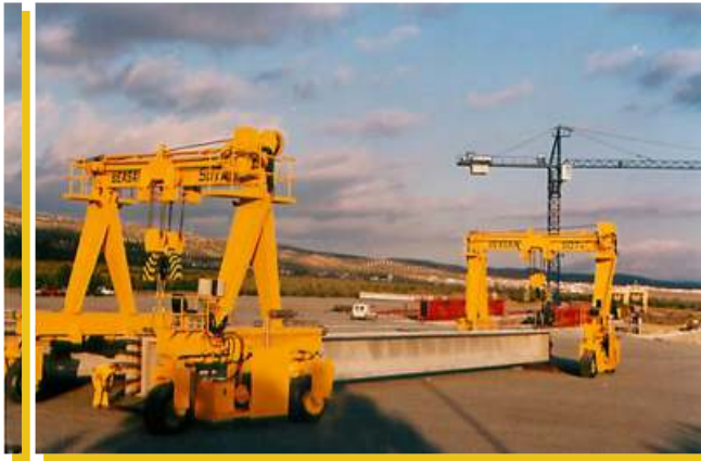
MANIPULACIÓN DE VIGAS DE HORMIGÓN
