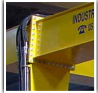
ESTRUCTURA ATORNILLADA FÁCILMENTE DESMONTABLE
